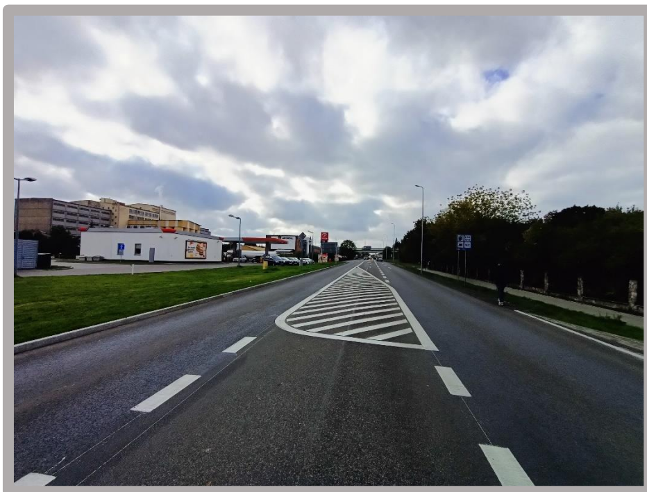
Droga 1286C po przebudowie. Źródło: własne PZD.
