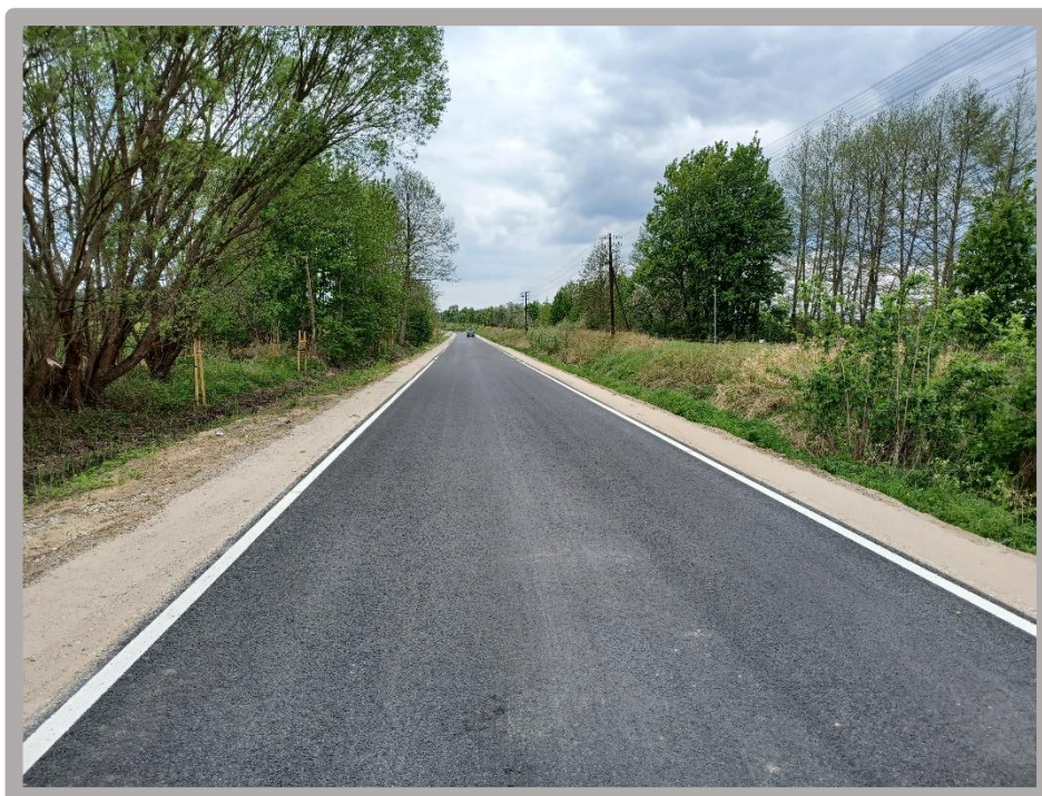
Droga 1254C po przebudowie. Źródło: własne PZD.
