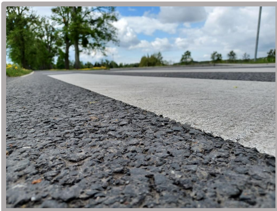
Droga 1254C po przebudowie. Źródło: własne PZD.
