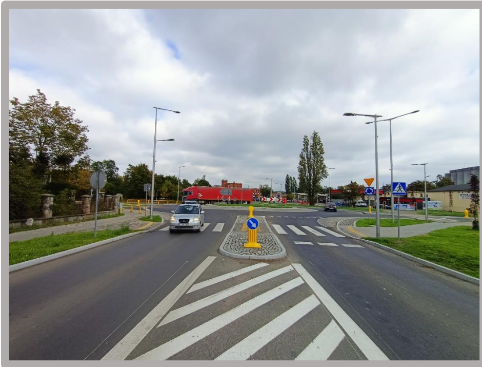
Droga 1286C po przebudowie. Źródło: własne PZD.
