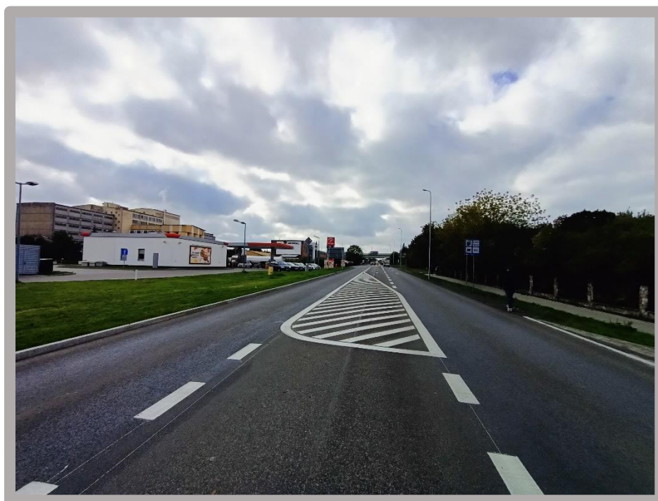
Droga 1286C po przebudowie. Źródło: własne PZD.
