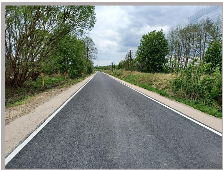
Droga 1254C po przebudowie. Źródło: własne PZD.
