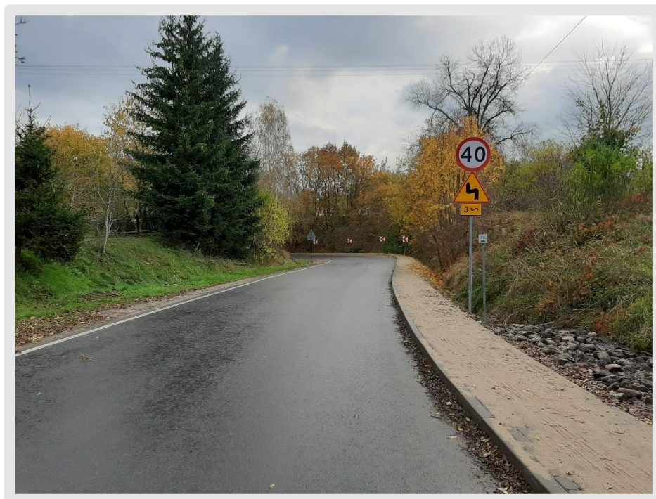
Droga powiatowa nr 1046C – 29.10.2020r.
