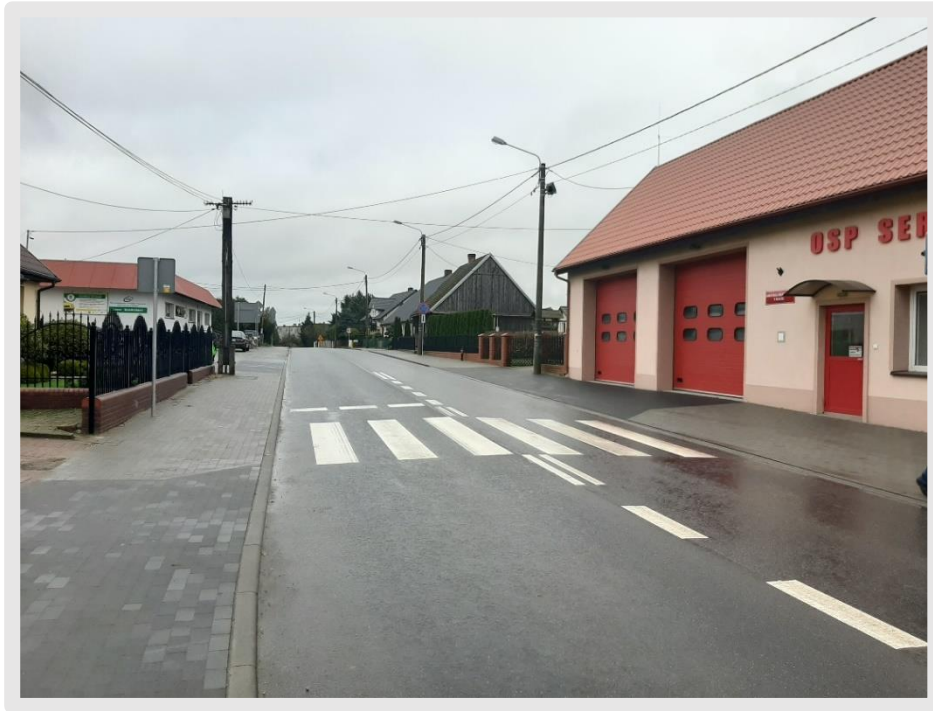
Droga powiatowa nr 1265C – 06.11.2020r.
