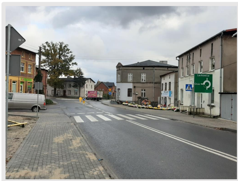
Droga powiatowa nr 1046C- 29.10.2020r.
