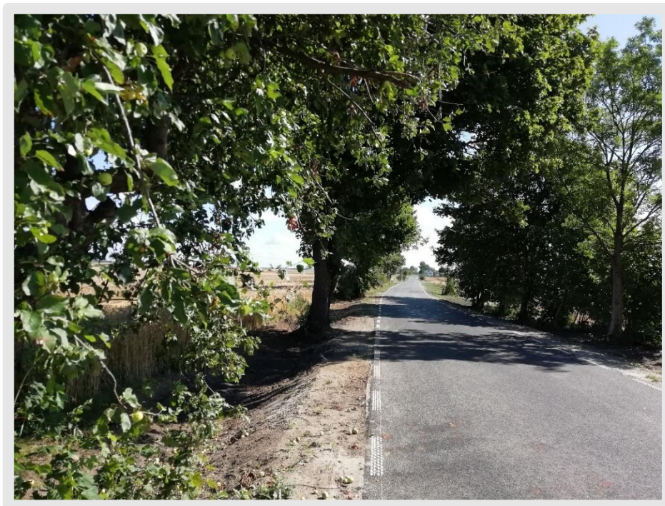
Droga powiatowa nr 1267C – 30.07.2020r.
