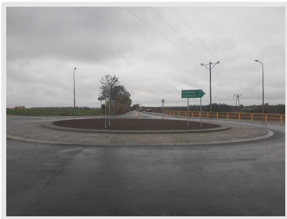
Droga powiatowa nr 1265C – 06.11.2020r.
