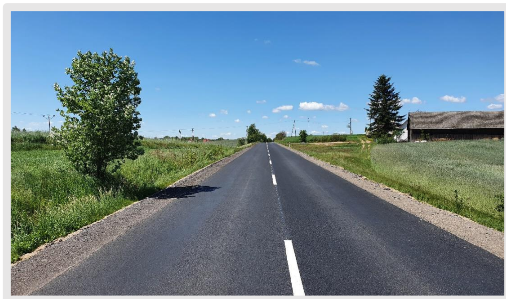
Droga powiatowa nr 1048C – 29.05.2020r.
