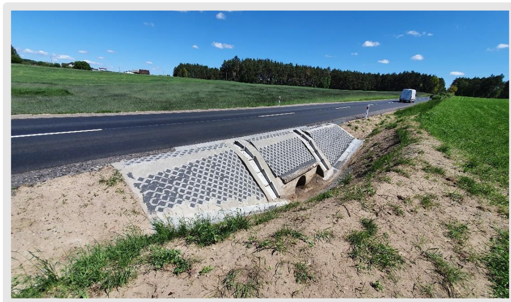
Droga powiatowa nr 1048C – 29.05.2020r.
