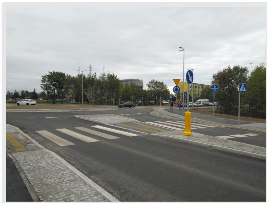
Skrzyżowanie drogi powiatowej nr 1252C i 1286C – 15.10.2020r.
