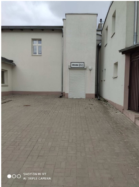
Zdjęcie nr 7: Istniejące wejście do budynku poprzez przejście windowe
