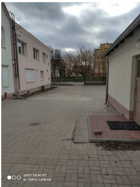
Zdjęcie nr 6: Istniejące miejsca dla osób niepełnosprawnych oddalone od wejścia do budynku ok. 25,0 m
