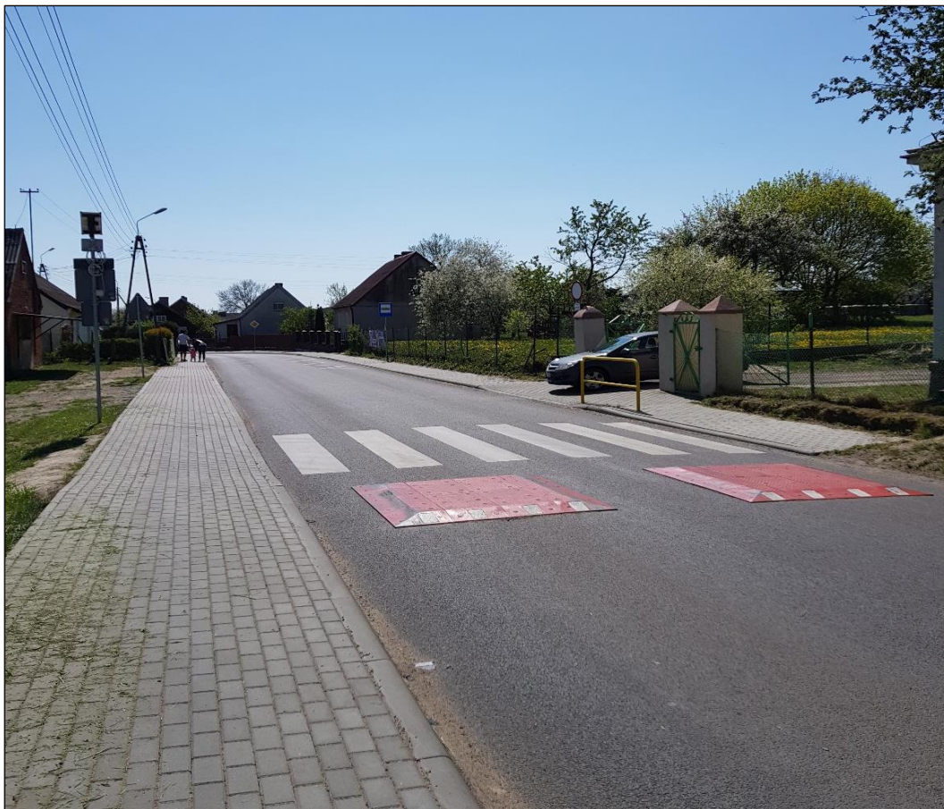
Rysunek 9 Droga 1212C - progi wyspowe przed przejściem dla pieszych w m. Sierostaw
