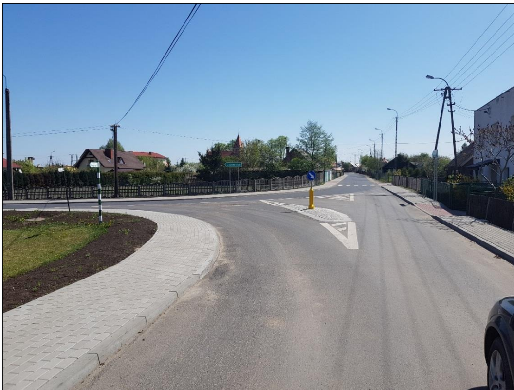
Rysunek 6 Droga 1204C - przebudowane skrzyżowanie z drogą gminną w Lipinkach
