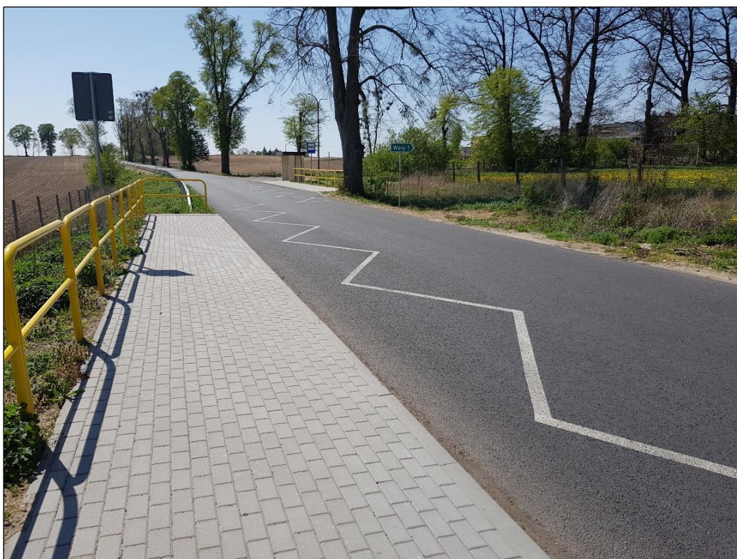
Rysunek 9 Droga 1212C - progi wyspowe przed przejściem dla pieszych w m. Sierostaw
