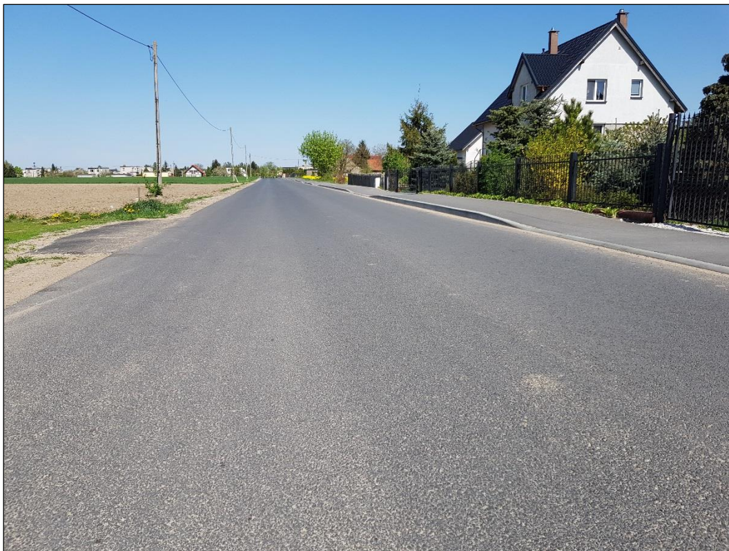
Rysunek 12 Droga 1270C - nowa jezdnia i chodnik o nawierzchni bitumicznej w m. Pruszcz
